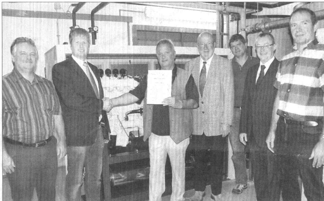
Bei der Inbetriebnahme des Blockheizkraftwerks in der Röslauer Kläranlage (von links): Roland Winter von der Firma Etamax, gKU-Geschäftsführer Stefan Webhofer, Dieter Sternecker von der Firma Enes, Bürgermeister Gerald Schade, Ingenieur Frank Riefle, Bürgermeister Frank Dreyer und Klärwerksleiter Rainer Hager. Foto: Wolfgang Lindner
