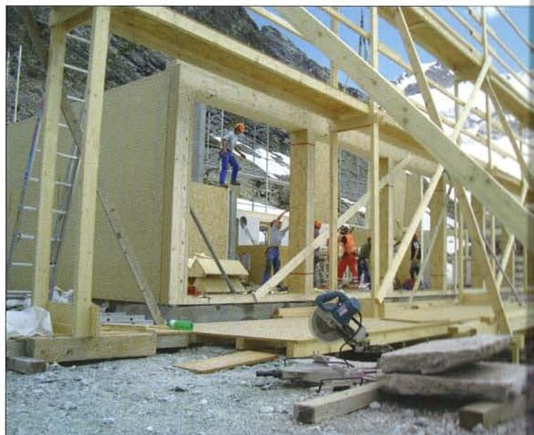
Les charpentiers assemblent l'ossature en bois de sapin préfabriquée. L'isolation thermique de l'enveloppe atteindra 20 cm d'épaisseur dans la façade. PHOTO BASERGA E MOZZETTI ARCHITETTI
