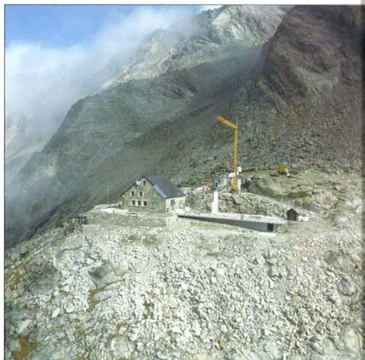
Les architectes quant à eux proposent des solutions durables. La pierre sortie des fouilles est réutilisée pour le socle de la terrasse et pour le socle de la nouvelle annexe. Les grands vitrages permettent de minimiser la consommation d'énergie. PHOTO BASERGA E MOZZETTI ARCHITETTI
