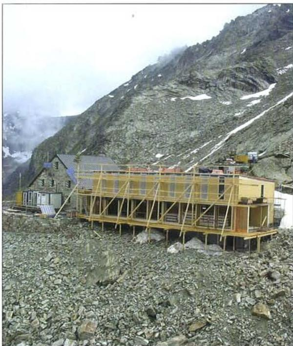
A gauche sur la façade orientée à sud-est, les panneaux solaires contribuent à la production d'énergie électrique. Les deux édifices sont chauffés par des poêles à bois et, si nécessaire, par une récupération de chaleur du groupe chaleur-force.
